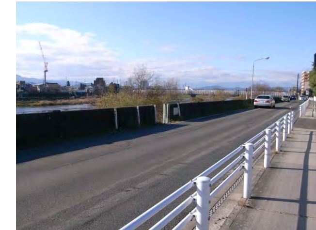
既設道路に隣接しており、容易にアクセスできない(交通量が大きく危険)状況にある
