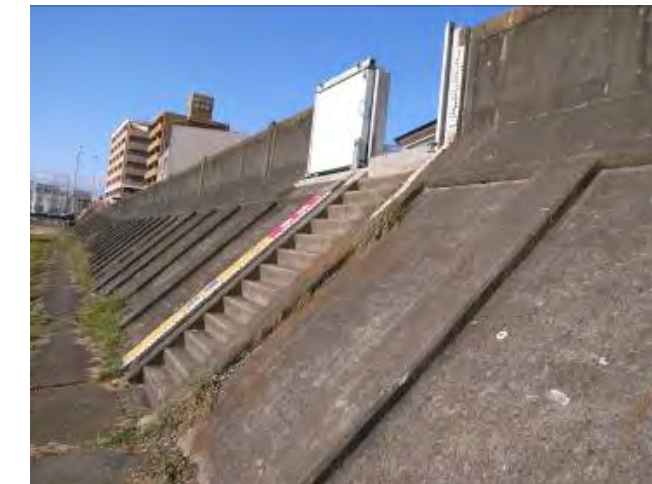
既設護岸(階段)の勾配は 1:0.5 (高低差約 4 m)
